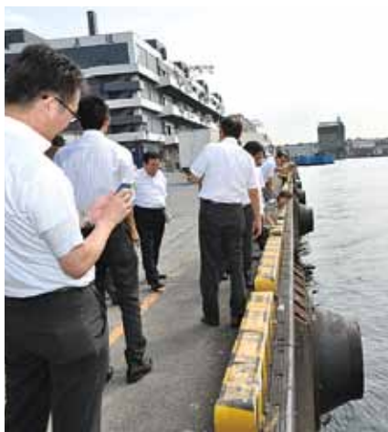
港湾施設の老朽化を視察 (H24年8月)
