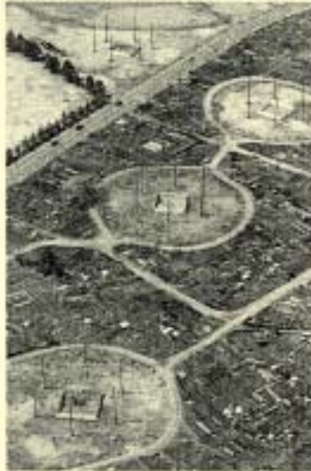
撤去されることが明らかになった深谷通信所の送信アンテナ
