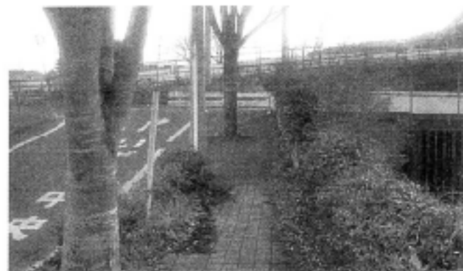
和泉川・赤坂橋付近
