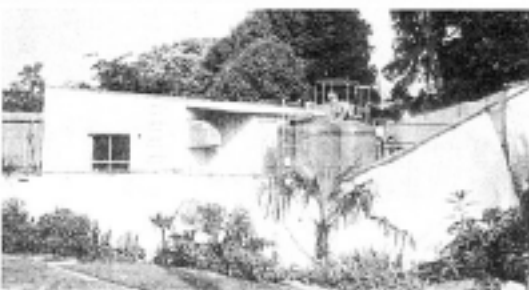
着々と工事が進む浄化施設(H16.5)
