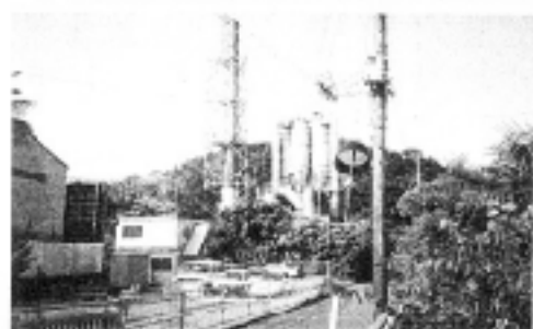
解体が始まる廃棄物焼却施設
